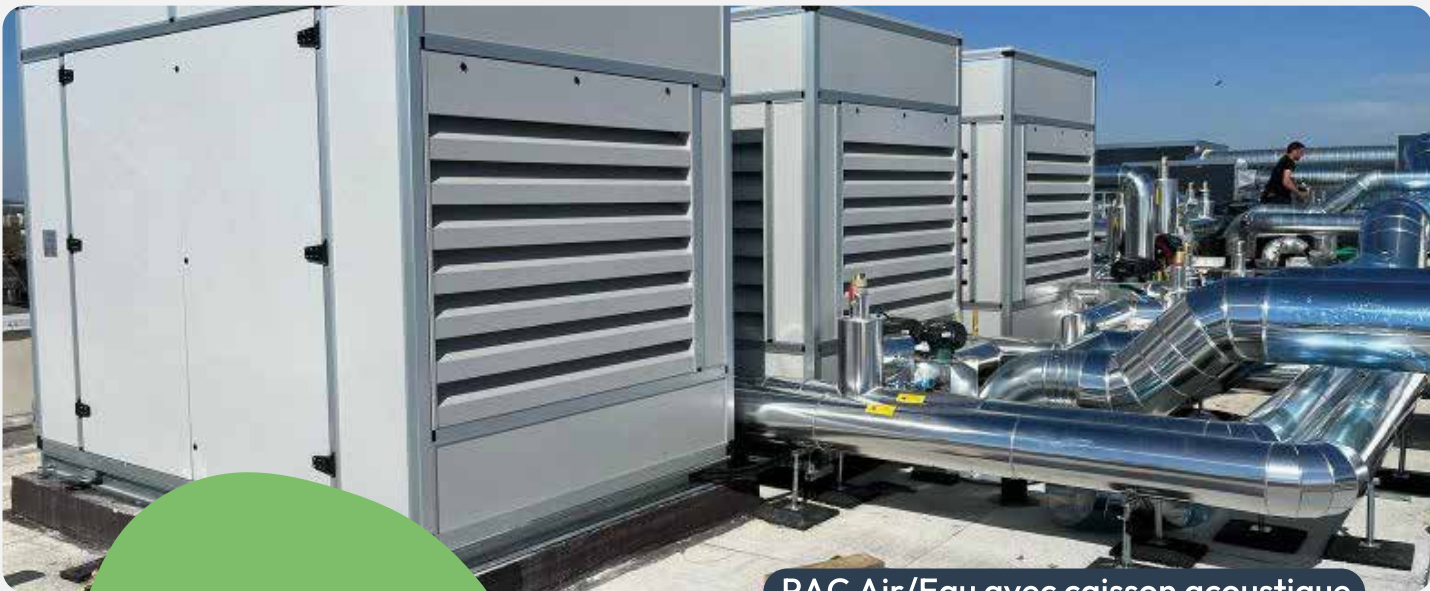
PAC Air/Eau avec caisson acoustique
