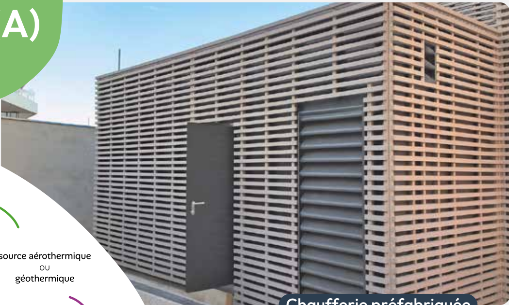
Chaufferie préfabriquée
